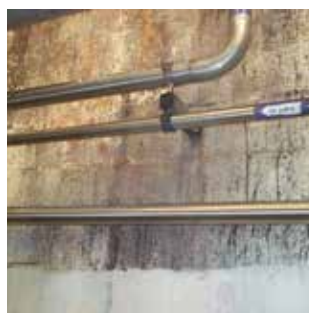
Pared antes de la aplicación
